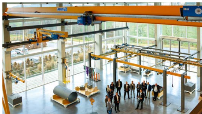
Auf 3 Ebenen warten unterschiedliche Kransysteme darauf von Ihnen ausgiebig getestet zu werden
