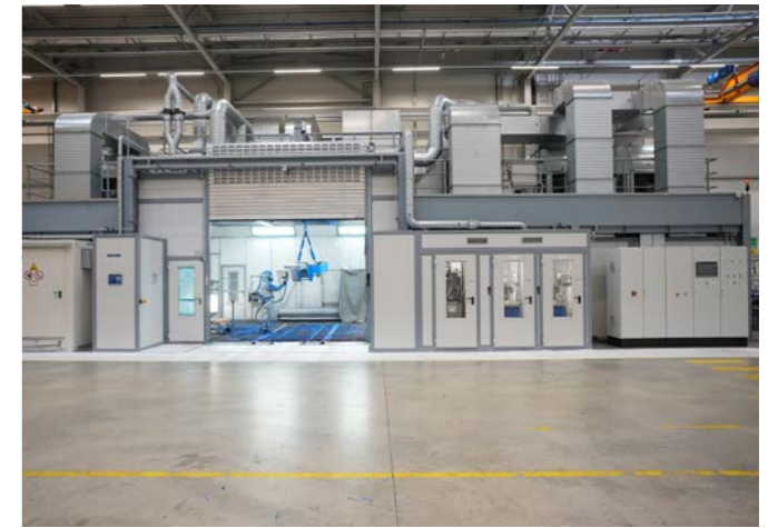
Korrosionsschutz und Oberflächenveredelung auf Basis von Wasserlacken
