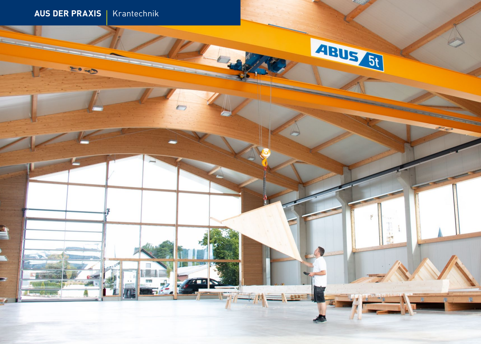
Im Vergleich zum Einträgerlaufkran erreicht der Zweiträgerlaufkran eine größere Hubhöhe – für Baierl wichtig, da die Traufhöhe der Halle durch die Bauvorschriften auf acht Meter beschränkt ist.
